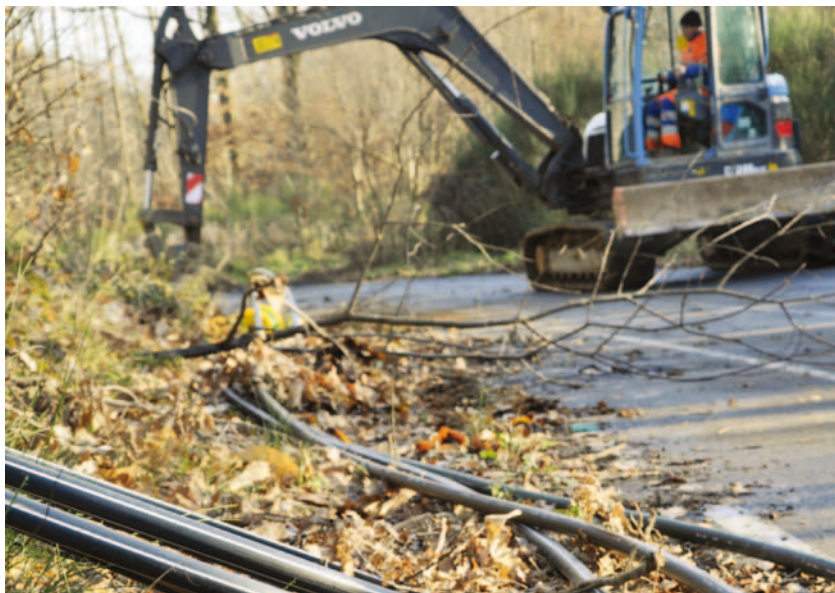
Allée Jacques Tati (ex-CR9), les premiers gros câbles ont été enfouis en janvier. Ils permettront l'accès au très haut débit pour tous les Urbisylvains et pour les personnes qui travaillent sur la commune, à l'horizon 2014.
